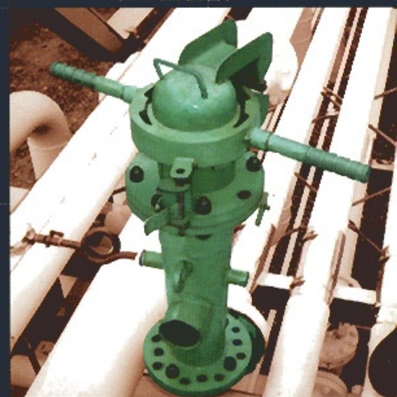
レシーバー (ピグ回収管)
